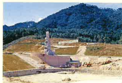
安佐動物公園・建設中のヒヒ山
