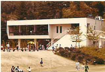
植物公園・食堂完成
