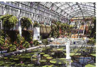
植物公園・熱帯スイレン温室完成
